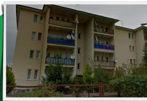
Şekil 4'de güneş panelinin kurulacak olduğu Çanakkale UEDAŞ lojmanlarına ait bir fotoğraftır.
